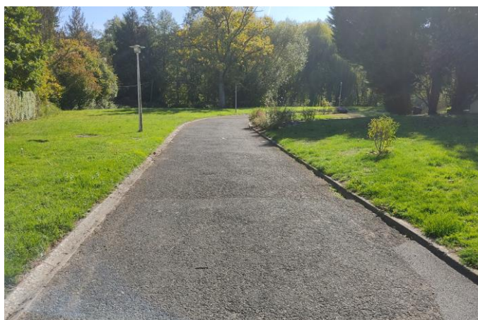
Photo Cheminement Extérieur entre parking et complexe sportif
