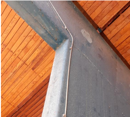
Photos points de rouille sur charpente
