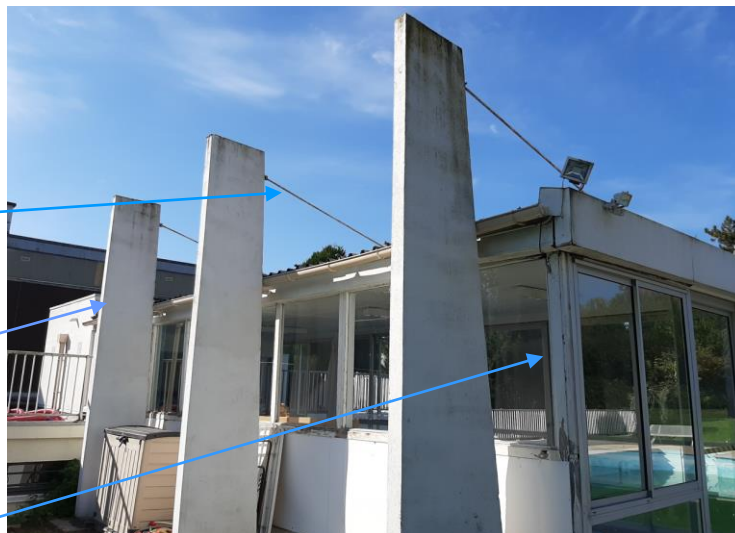
Structure véranda piscine
