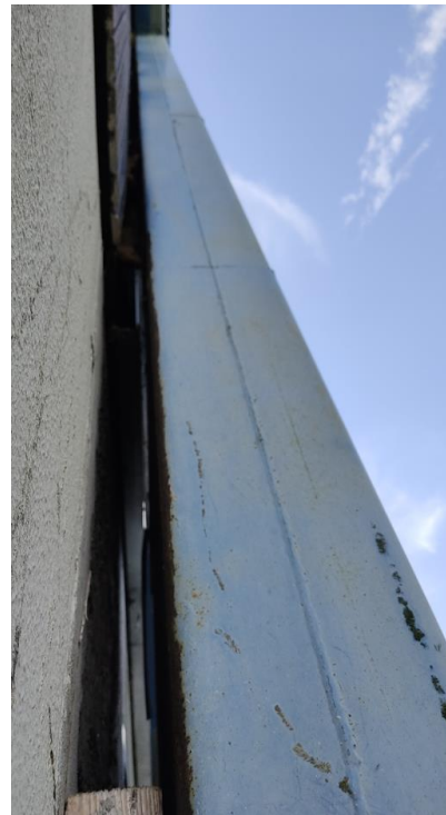
Photos corrosion sur poteau métallique extérieur
