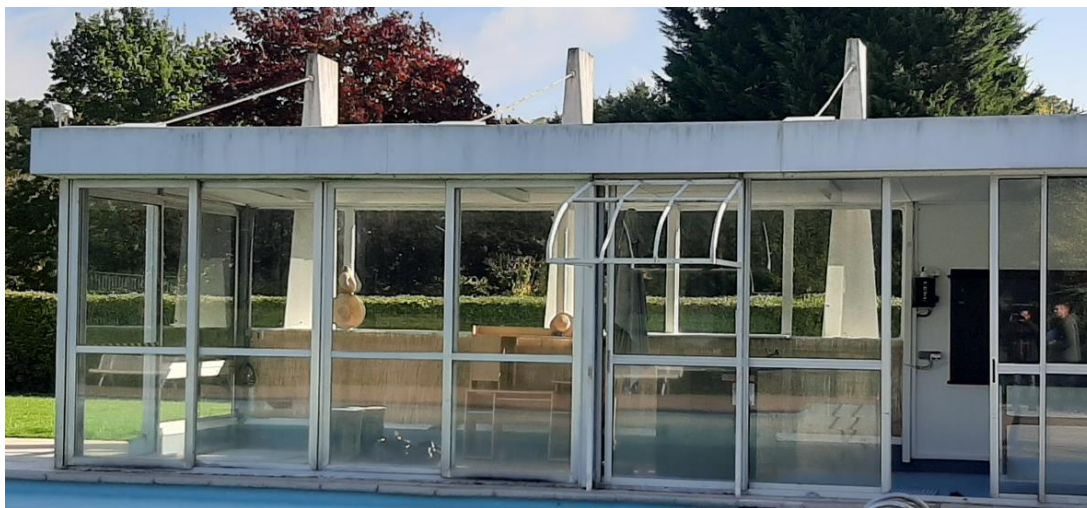
Photo façade véranda remplissage éléments verriers
