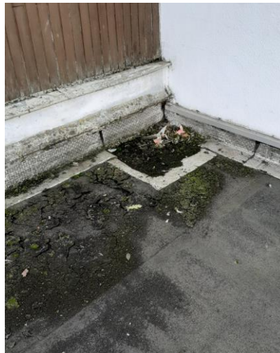
Photos entrée d'eaux pluviales bouchées.
