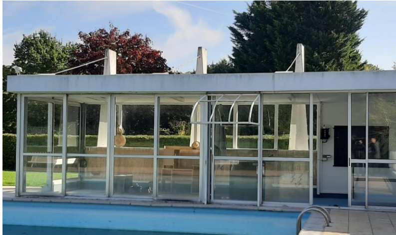
Façade sur laquelle des poteaux sont à créer
