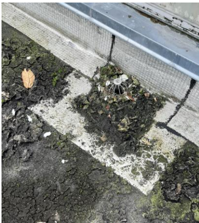
Photos entrée d'eaux pluviales bouchées.
